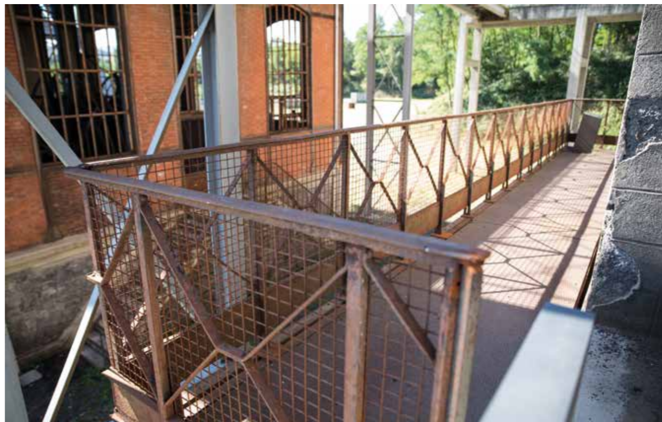
Fabrication à l'identique des garde-corps et de la passerelle
