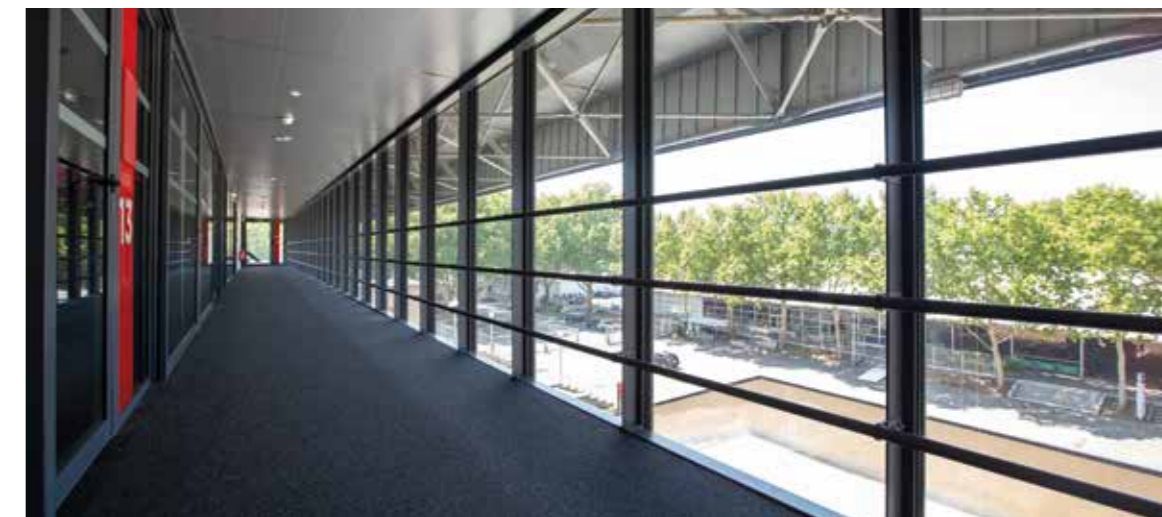
Vue intérieure du mur rideau • Mains courantes métalliques
