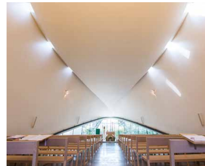
12 puits de lumière zénithale en menuiserie acier
