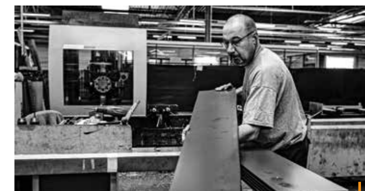
Jacky • Travail sur l'ossature de la façade
