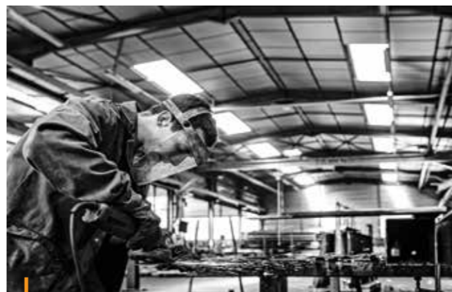
Fabien • Réalisation d'un élément de garde-corps
