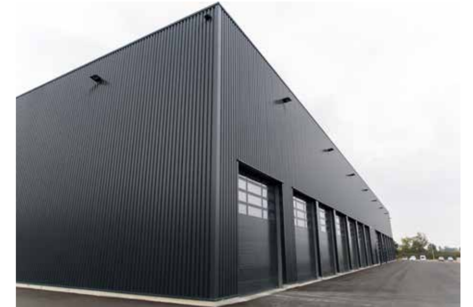
Charpente couverture bardage métallique et portes sectionnelles
