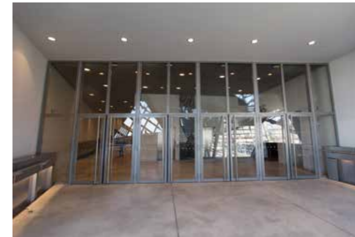
Portes acier intégrées dans un mur rideau périphérique
