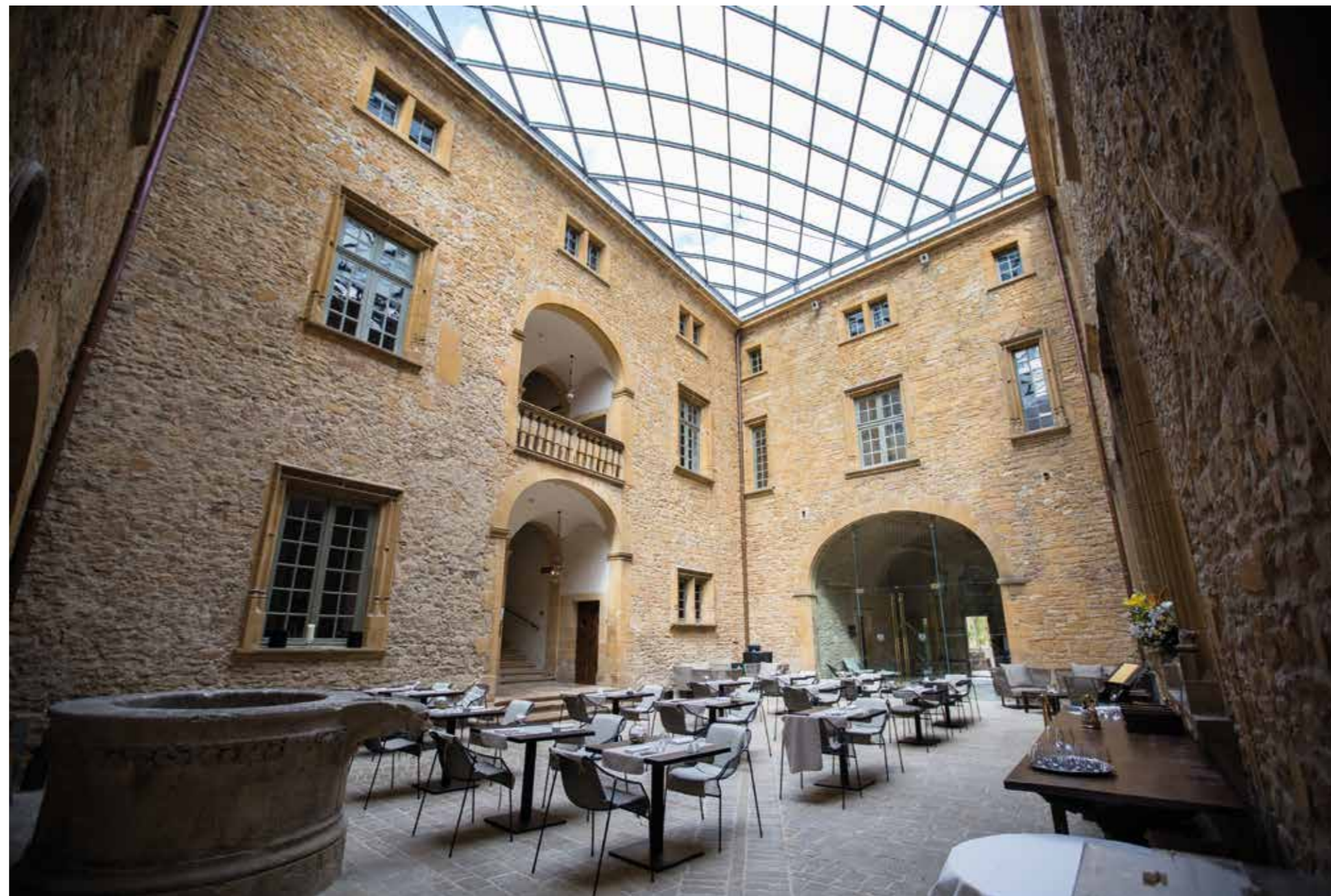
Verrière surélevée en acier avec ossature métallique et vitrages uniques en losanges.
