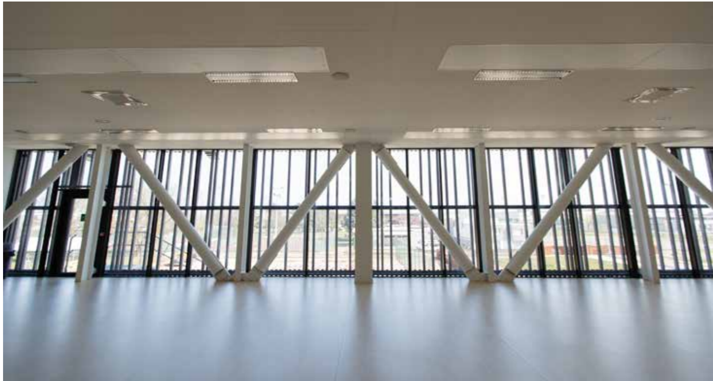
Charpente treillis métallique apparente qui assure la stabilité des portes-à-faux
