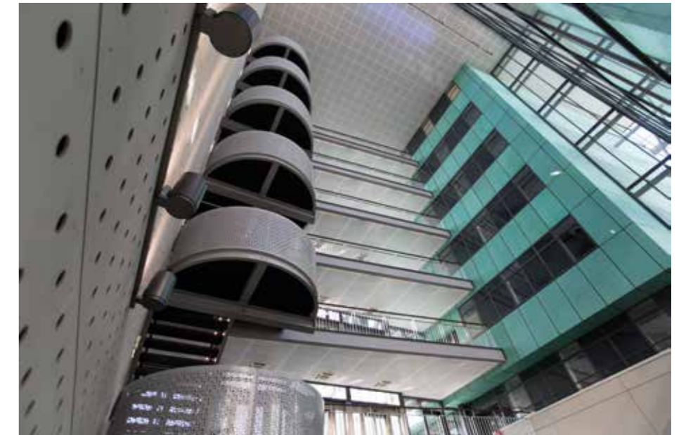
Escalier porte-à-faux métallique en tôle perforée • Passerelles acier avec garde-corps barreaudés • Atrium châssis coupe-feu
