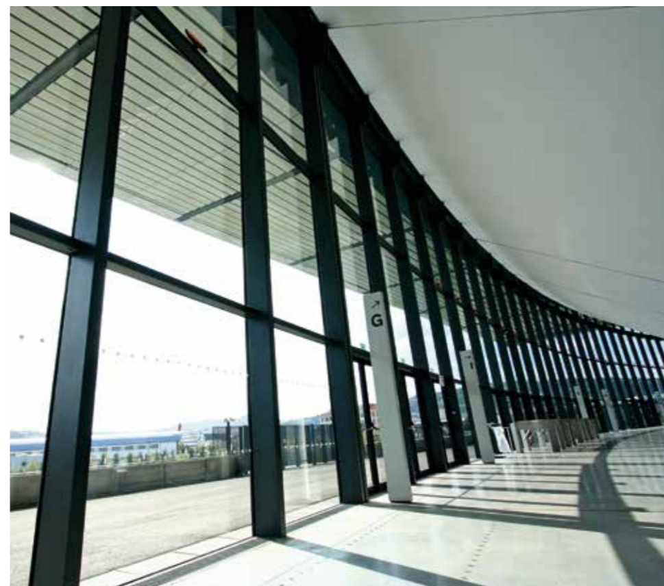
Ossature façade vitrée • Portes d'accès
