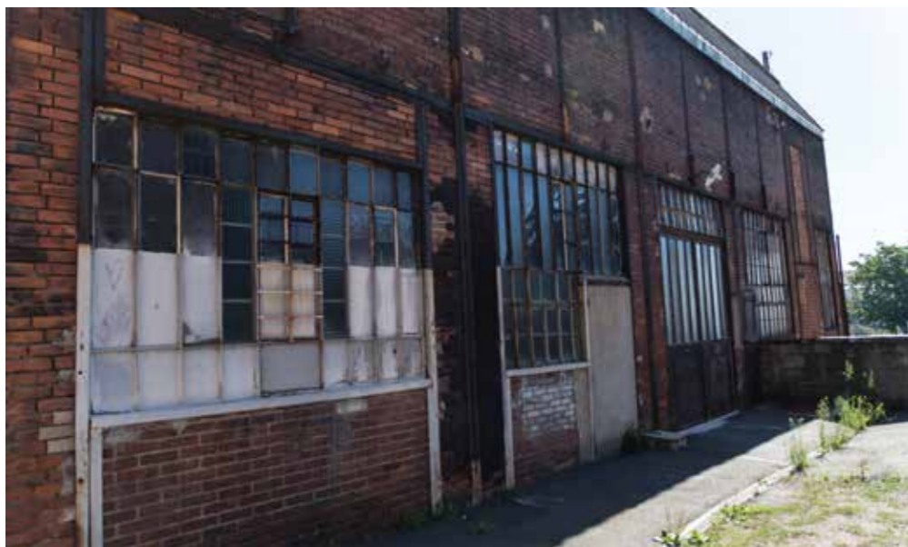
Restauration à l'identique des menuiseries et vitrages
