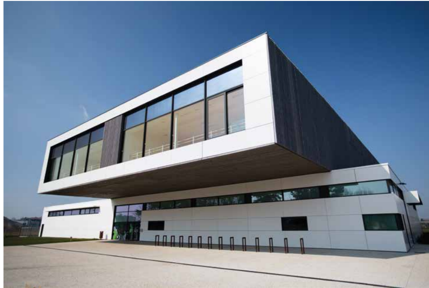
Charpente métallique avec 8 m de porte-à-faux d'un côté et 4 m de l'autre • Menuiserie aluminium formant une bande filante en périphérie du bâtiment • Mur rideau aluminium à l'entrée et châssis d'angle à vitrages à bords collés
