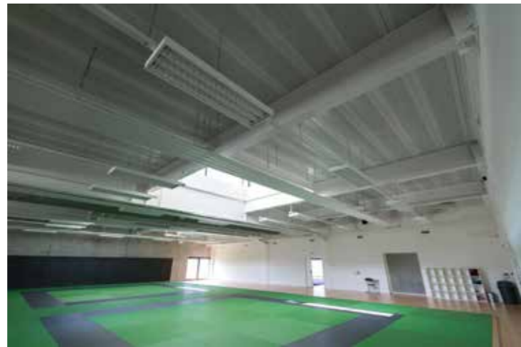
Charpente métallique avec coffres à dalles perforées
