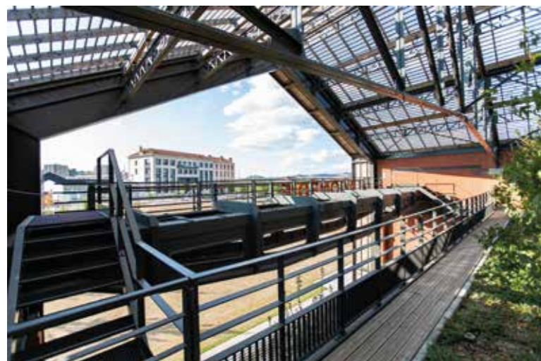
Vue intérieure du pignon • Garde-corps d'accès au pont roulant
