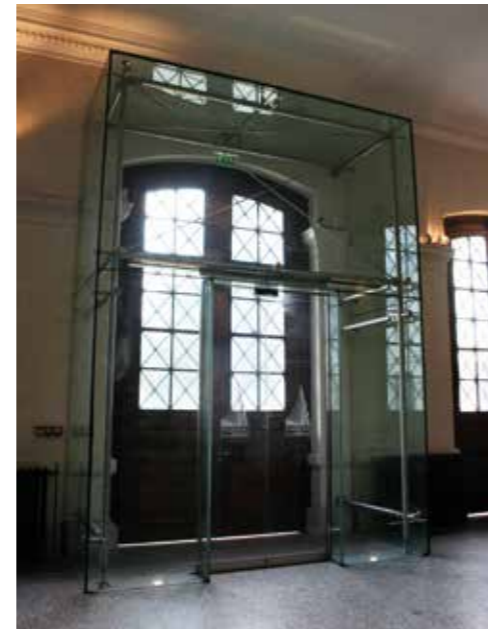
SAS d'entrée vitré
