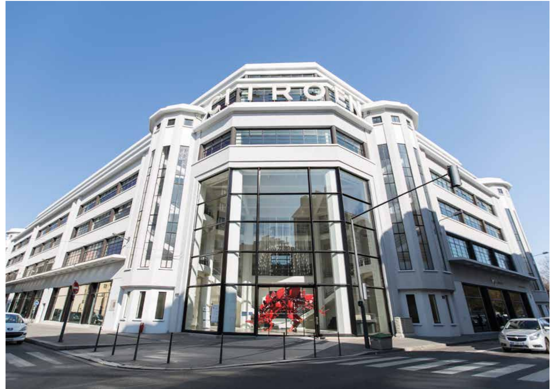
Châssis verticaux et horizontaux en fer cornières et fer en T reproduits à l'ancienne
