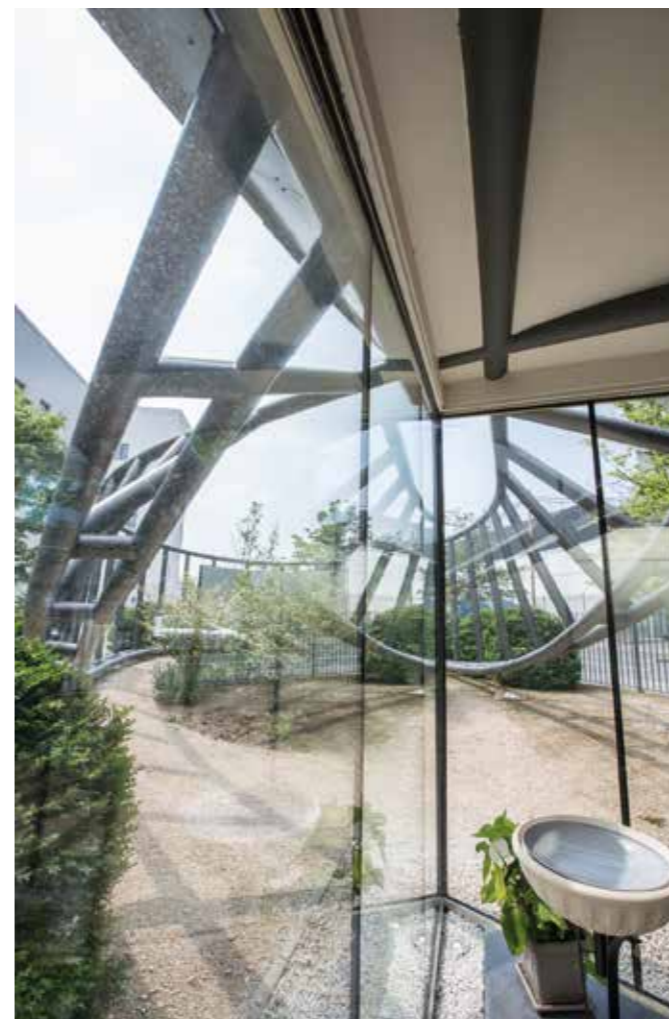
Vitrages à bords collés pris en feuillure haute et basse
