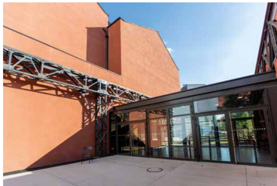
Galerie de liaison • Mur rideau aluminium • Rénovation de la charpente métallique
