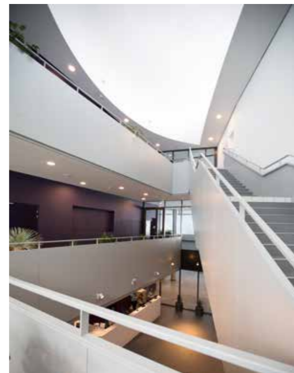
Escaliers intérieurs en acier avec marches caisson et garde-corps en tôle laquée
