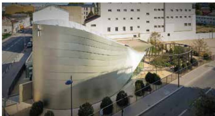
Charpente métallique en tube acier représentant l'infini en 3 dimensions.
