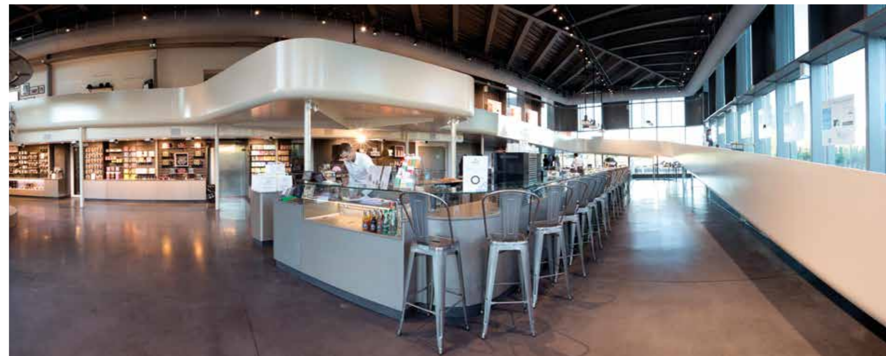
Passerelle métallique en tôle roulée
