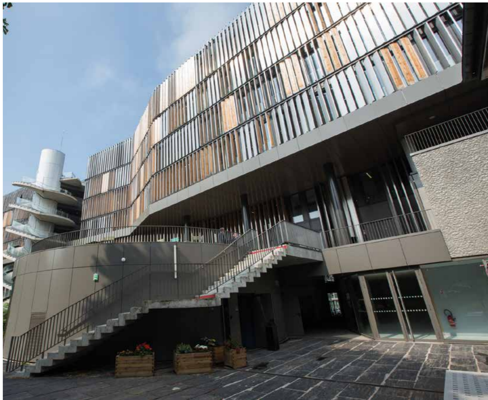
Réalisation des châssis aluminium extérieurs avec volets bois inox • Parement de façade en panneaux bois composite cintrés • Garde-corps en vitrages cintrés sur escalier hélicoïdal
