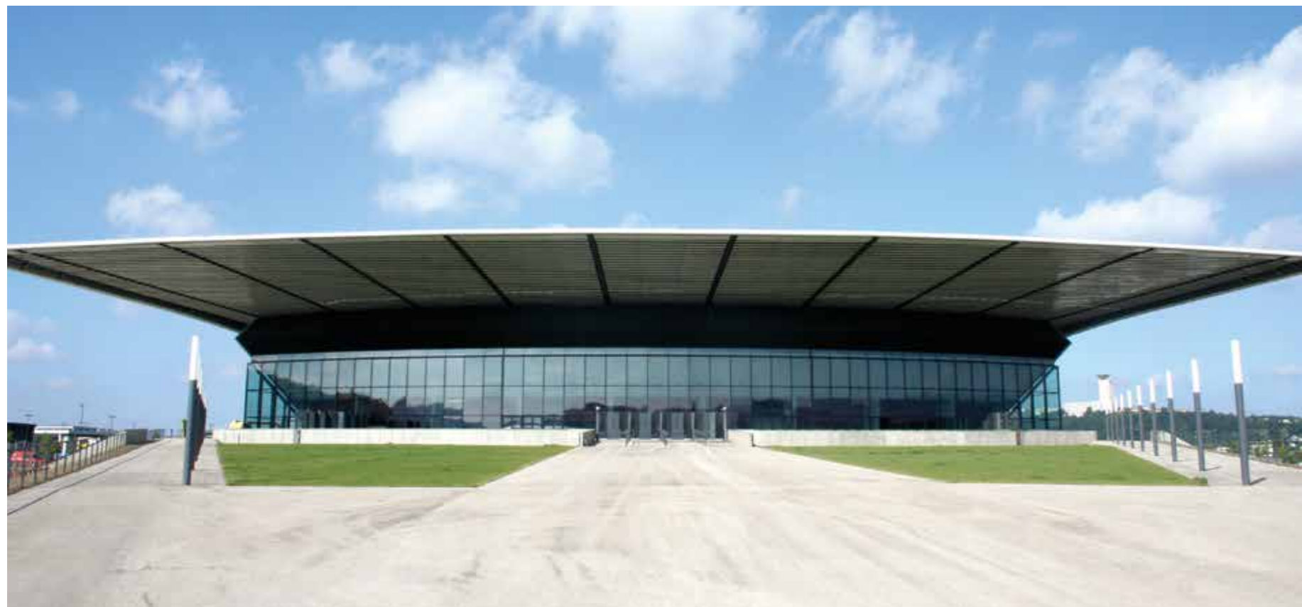
Ossature façade vitrée • Portes d'accès
