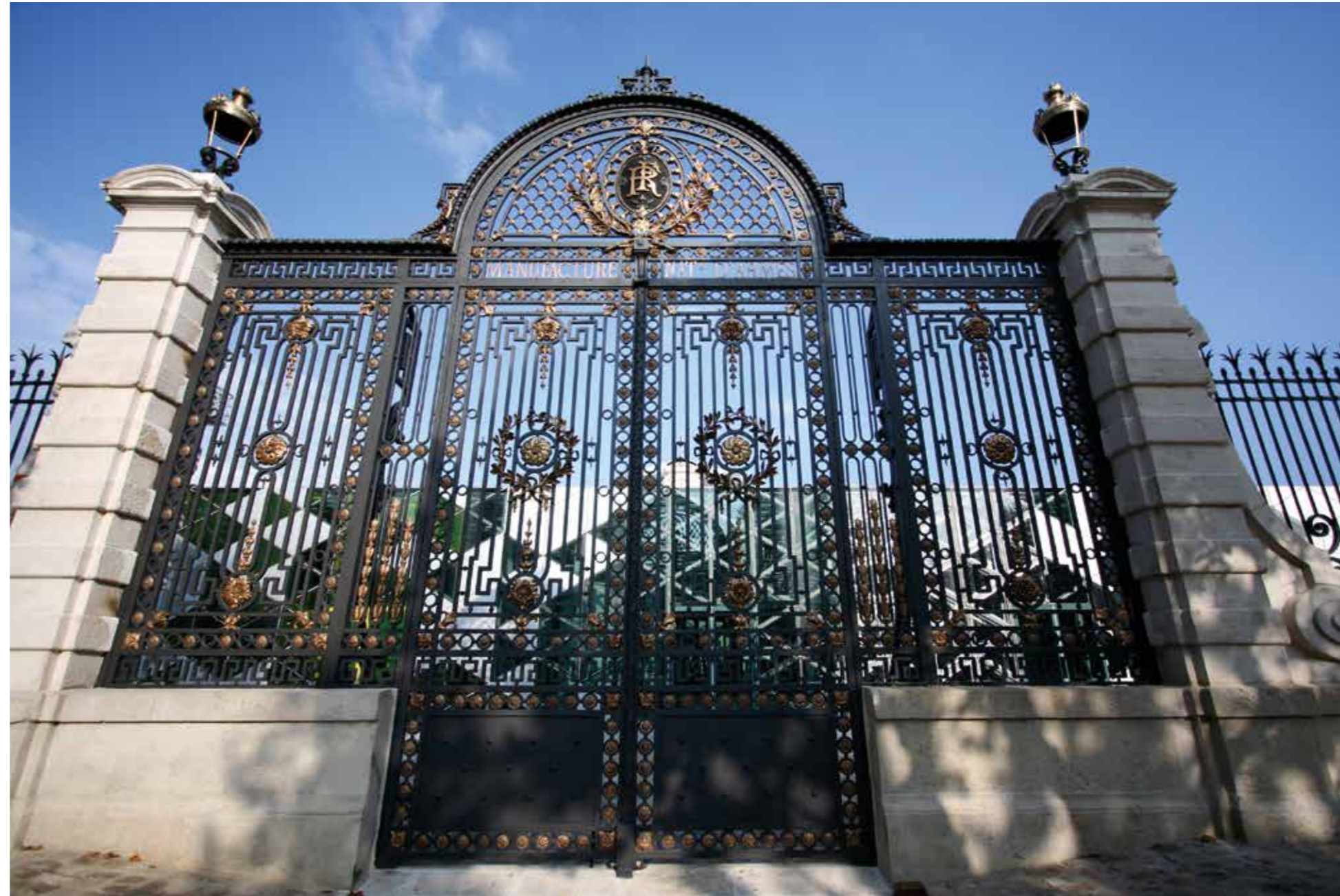
Restauration de la grille de la Manufacture • Grenailage de l'ouvrage • Gommage des bronzes • Remontage à l'identique
