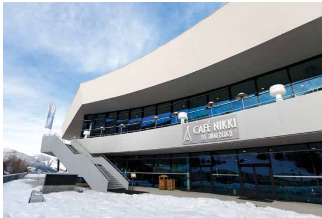
Escalier et passerelle métalliques extérieurs
