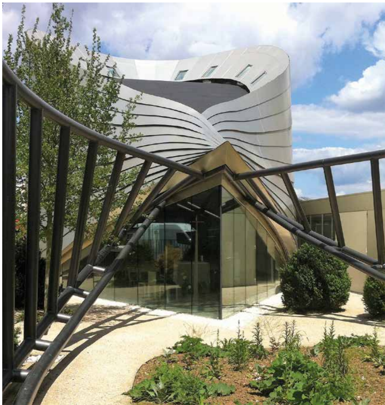
Couverture étanchéité bardage réalisé en tôles aluminium anodisées grande longueur
