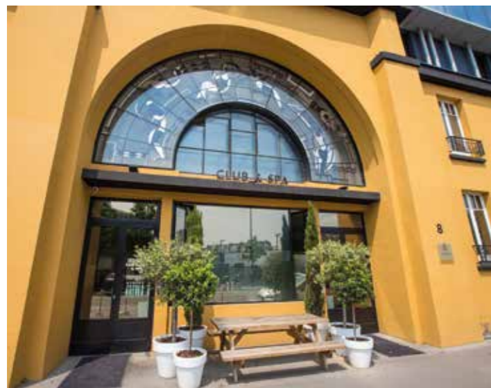
Châssis cintré en acier protégeant les vitraux
