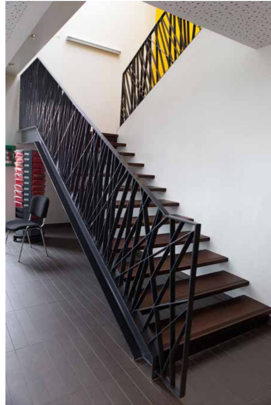
Escalier métallique avec garde-corps bambou et marches bois
