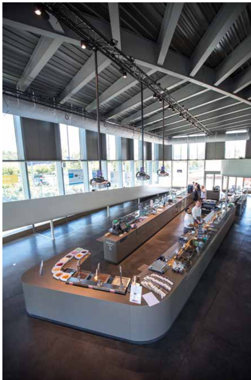
Charpente métallique avec faitage en forme d'arêtes
