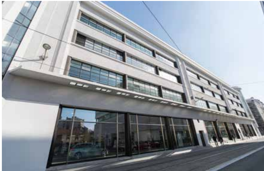
Châssis en fer cornières et fer en T à rupture de ponts thermiques
