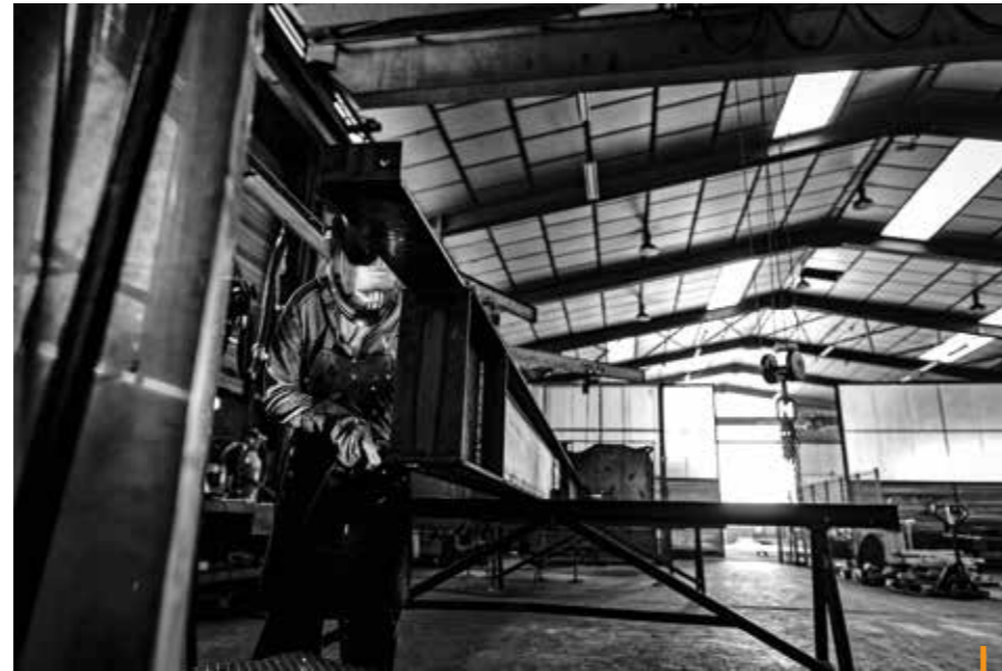
Gérard • Soudure d'un élément de charpente
