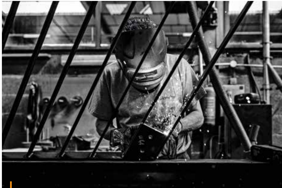
Travail sur les garde-corps
