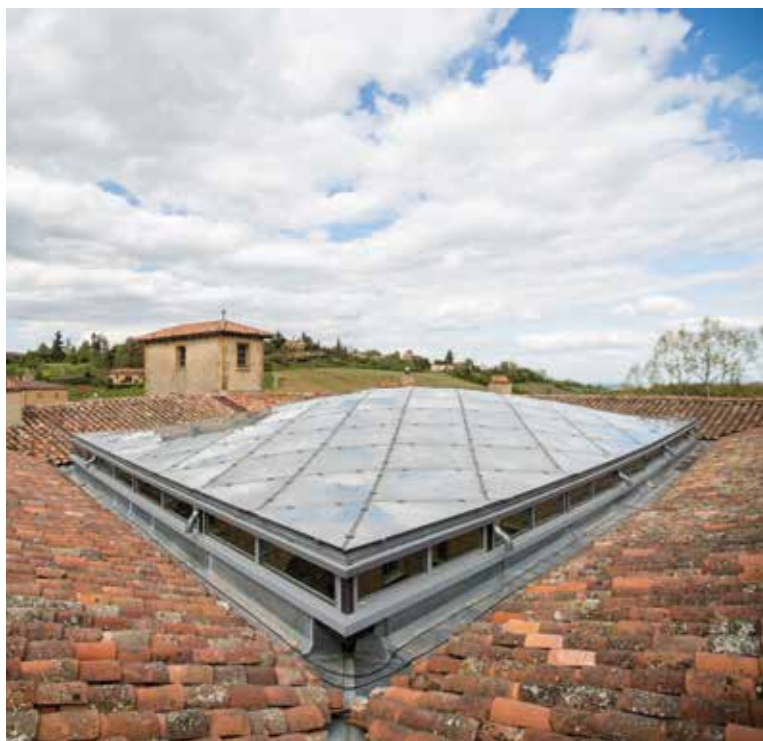
Verrière surélevée en acier • Châssis de désenfumage et d'aération en périphérie
