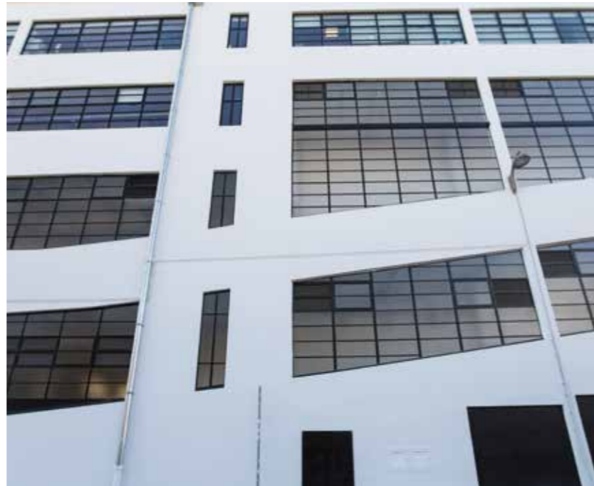
Châssis en fer cornières et fer en T asymétriques
