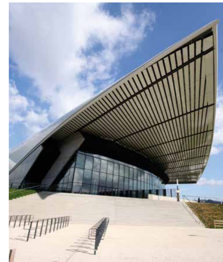
Ossature façade vitrée acier
