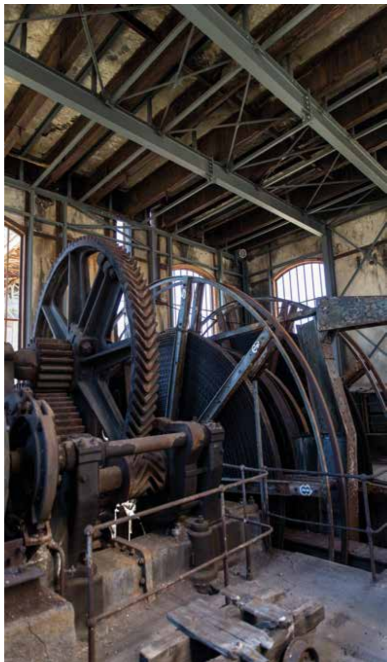
Renfort de la charpente existante du bâtiment en ruine
