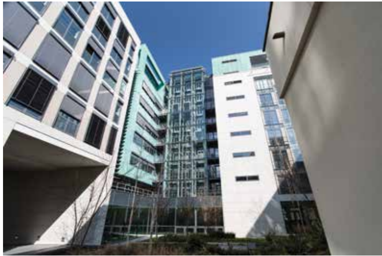
Cage d'ascenseur triplex vitrée
