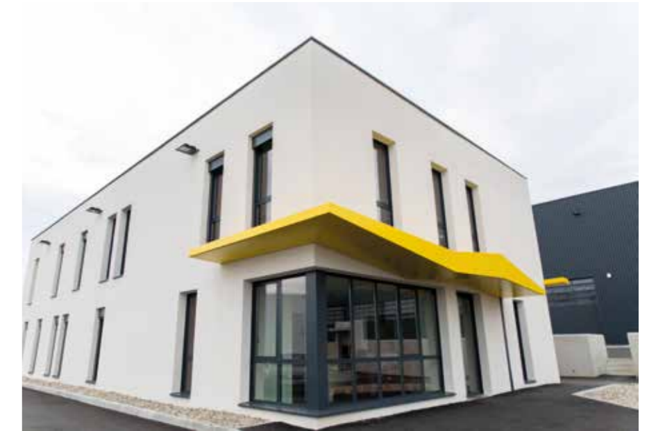
Devanture composée de châssis aluminium et BSO • Auvent métallique jaune mis en forme.
